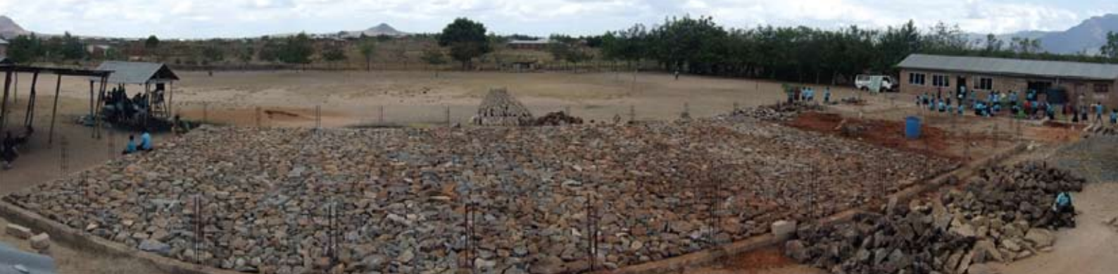
ELU Children Care, Tansania. Ein Fundament eines Schulhauses, gebaut von Jugendlichen, geplant im Idem Büro Basel.
